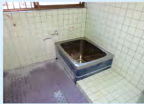
既存の浴室内部解体まえ
