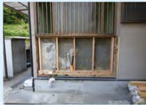
浴室壁内部補強材取付
