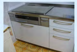
IH(ビルトイン)設置
