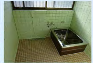
浴室内部リフォーム完了
