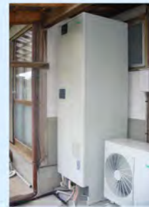
エコキュートの取付
