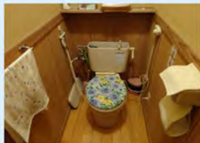
操作レバー一部の不良
