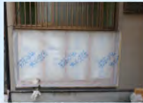
浴室壁内部断熱材装着
